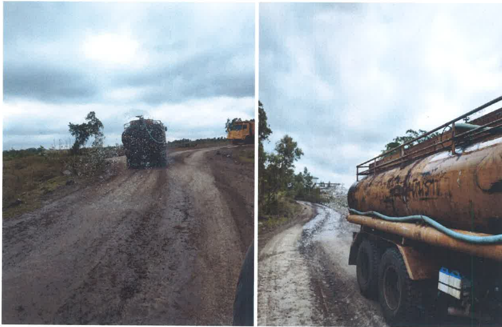
( รูปที่ 3 ) การฉีดพรมน้ำบนเส้นทางภายในโรงโม่
